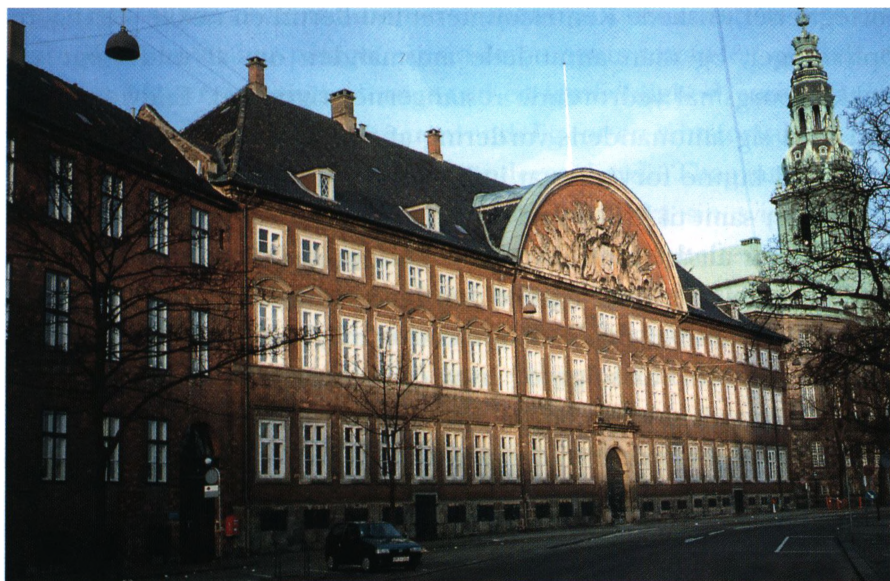
Kancellibygningen – »Den røde Bygning«, opført 1716-1720. Hovedsædet for centraladministrationen var Kancellibygningen i København, og Rentekammeret havde således også sine kontorer her. I Rentekammeret blev gennem årene behandlet et meget stort antal sager, som var af betydning for Thagaard, vedrørende såvel hans ansættelse som de opgaver, han varetog som embedsmand.
