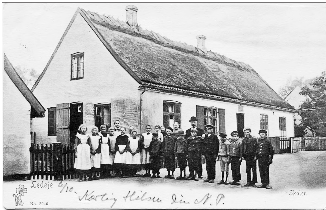
Fig. 3. Ledøje Rytterskole, her fotograferet i 1903, var i brug indtil 1927. På dette tidspunkt var skolen godt og vel 200 år og fremtrådte stærkt forandret i forhold til den bygning, som blev opført under Frederik IV i 1720'erne. Stråtag havde erstattet tegtag, idet det oprindelige valmtag var blevet lavet til et saddeltag, og murværket var blevet pudset og kalket. Man kan dog stadig skelne placeringen af sandstenstavlen med inskriptionen over indgangsdøren. Huset blev siden solgt til privat beboelse. I 1959 blev tavlen flyttet og opsat på den daværende kommunale centralskole i Smørumovre, nu Søagerskolen. Foto: Ledøje-Smørum Lokalarkiv.
