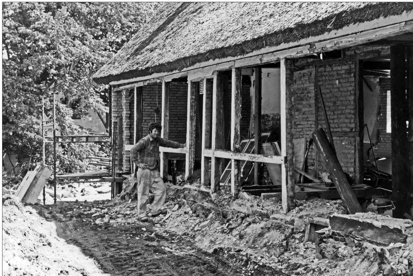
Tysmosegård 1982. Elo Jensen river det sidste bindingsværk ned. Foto: Forfatteren.
