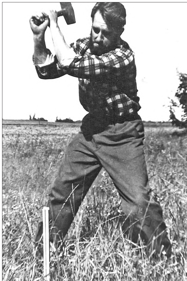
Min gamle klassekammerat, tømrermester Knud Jørgensen, afsætter til støbning af fundament i 1959. Privatfoto.
