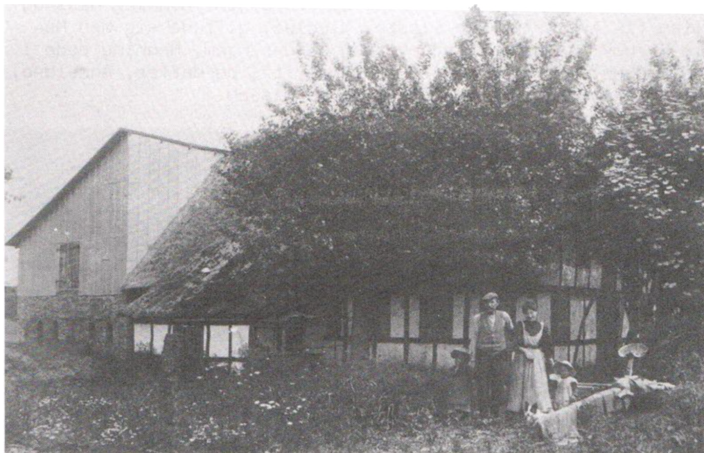
Ejendom ved Brandsbøl Skov, nedbrudt i 1916
