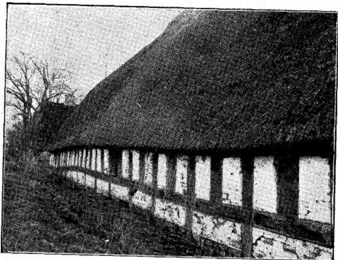
Fig. 6. Ladelængens Nordside. Den ældste Del af Præstegaardens Bygninger.
