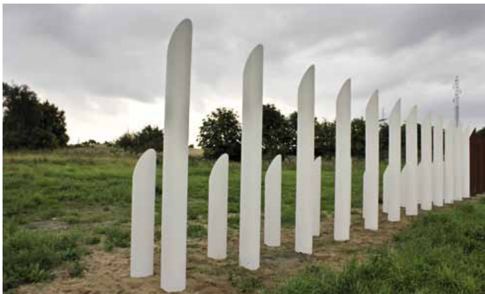
På Gammelmark i Vejle Nord er lavet en forsøgsopstilling af en palisademarkering i lysgrå-malet beton. Stolperne her er halvanden og tre meter høje. De høje skal formentlig være 3,5 meter høje. Foto: Leif Baun.
