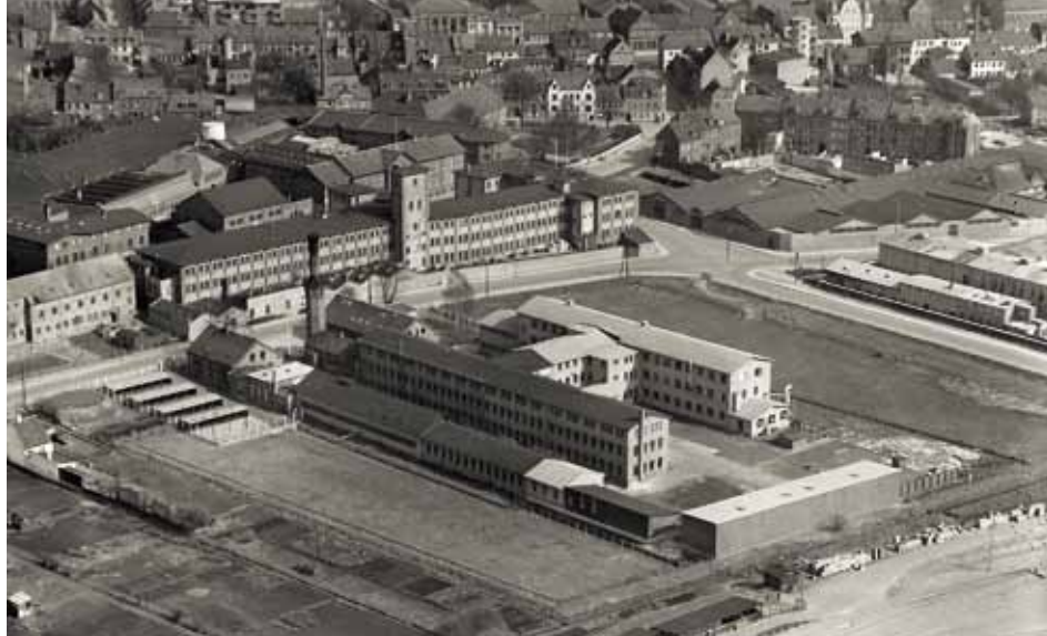
Luftfoto fra 1938 af fabrikskvarteret. Forrest ses Kr. Kirks Telefonfabriker, bagved Hede Nielsens Fabriker A/S og til højre de sorte lave bygninger, Skandinavisk Rørfabrik.
