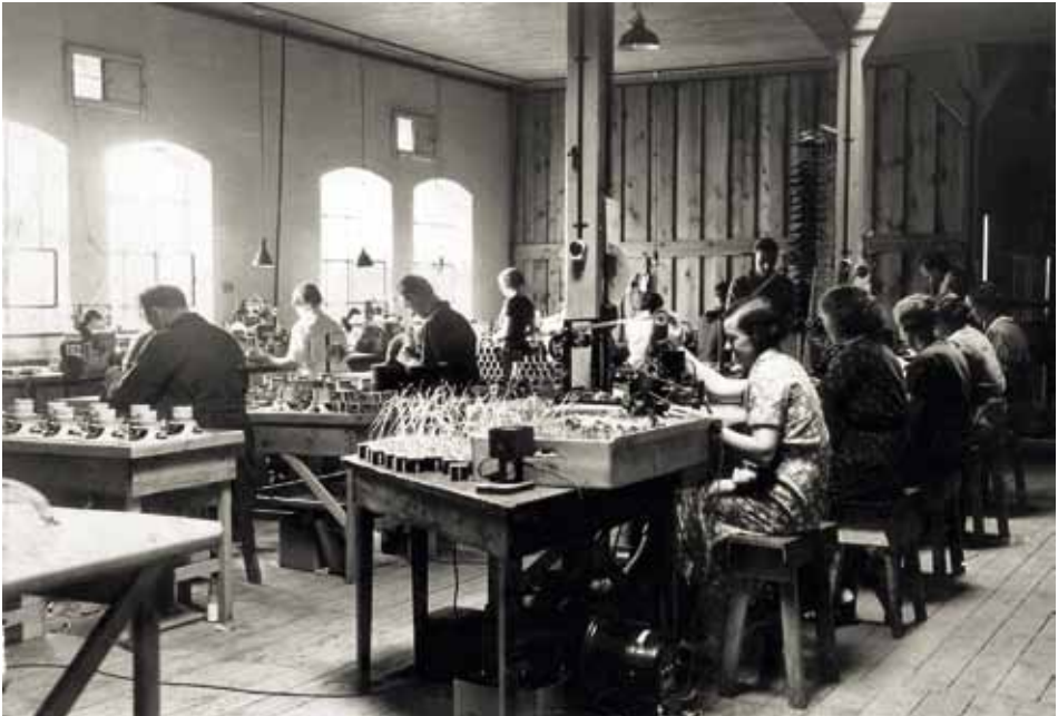
Radiofabrikkens højtalerværksted. Til højre vikles drosselspoler, til venstre montage af højtalere.
