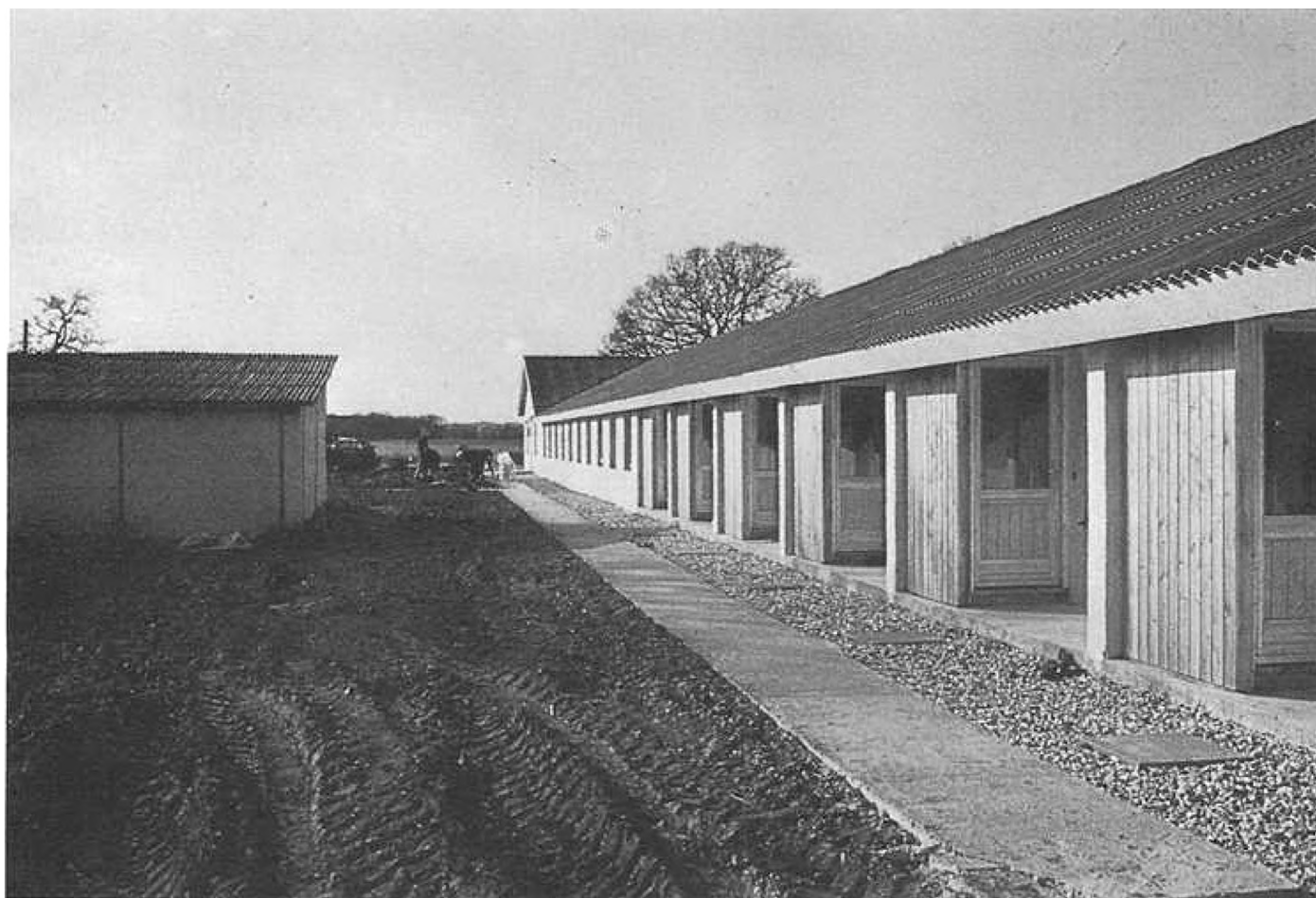
Da den nye boligfløj var færdig i 1974, begyndte ashramitterne straks at anlægge en have rundt om bygningen
