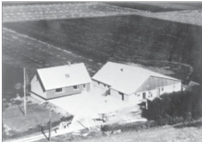
49. Gitte og Otto Serup, Ballerumvej 100. Det nye stuehus er bygget. Ca. 1962.
