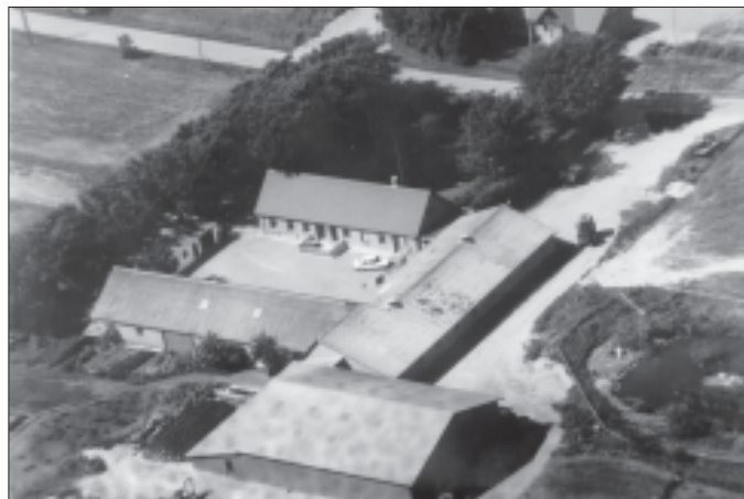
37c. Poul Overgård, "Munkholm", Brundvej 6. Ca. 1985.
