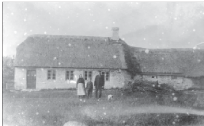
52a. Kirsten og Peder Madsen med sønnen Ingvard. Stuehuset er nyopført, ca. 1895. Gulvet i stuen er skibstømmer. Gulvet lå der stadig i 1995, men var slidt med knaster. I øvrigt meget flot, når det var nyferniseret.
