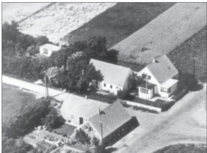
7a. Anders Jensen, Tousgårdsvej 15. Huset måtte vige for en vejmlægning i 1960'erne. Købmandshandelen, der også er med på billedet, måtte vige ved samme lejlighed. Ca. 1948.
