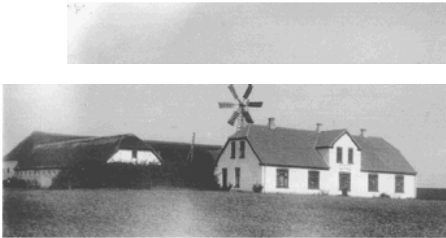
Den gamle præstegård med nyt stuehus (bygget ca. 1920).
