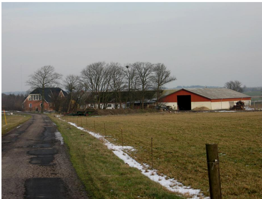
Sønderlund, 2006, stuehus under ombygning, eget foto
