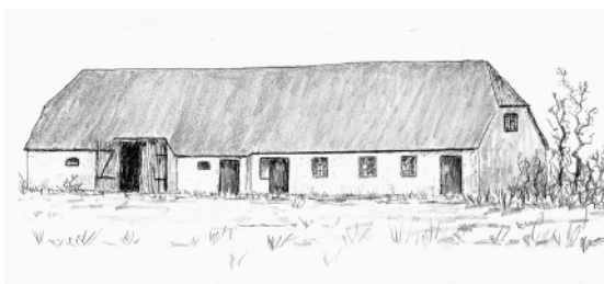
Else Møllers tegning af ejendommen, der blev nedrevet efter novemberstormen i 1981.
