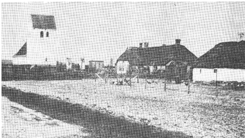
Fig. 9. „Harboøre By“ – efter postkort (Lemvig Museum) fra tiden mellem 1898 og 1909. Kirken blev ombygget 1909, og mindesmærket for det druknede redningsmandskab fra Liløre blev rejst i 1898. Dette monument ses lige til venstre for „Kirkehus“, hvis nordfløj (litra a og c) altså endnu på det tidspunkt eksisterer, her set fra nordvest, mens Gustav Møllers tegning viser husene set fra syd.
