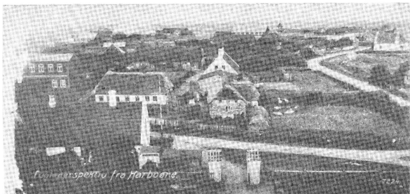
Fig. 10. Dette „fugleperspektiv“, udsigt fra kirketårnet med nuværende Norregade til højre, må være en smule yngre end fig. 9, idet den gamle stråttækte sløj af bagerens nu er erstattet af en lav rødstensbygning med ret sladt tag. Billedet kan dog ikke være fra senere end 1911, hvilket år det affotograferede postkort er stemplet. (Kortet tilhører landpost Niels Bros datter og svigersøn, Birnsvej 3, Lemvig). Fugleperspektivet giver – i udvidet betydning – et ganske godt overblik over Kirkebyens udvikling: „Kirkehus“ (litra a, c og d) foran bagerens som centrum. Jordemoderboligen ses forrest til venstre, og bagved den toetager, som C. L. Rønn i sin tid lod bygge til bl. a. manufakturhandel, hvor det ældste „Kirkehus“ må have været. Mellem toetageren og bagerens, lidt tilbagetrukket, ligger slagter C. L. Laugesens bygning fra o. 1885, der endnu synes at have stråtag. Til venstre herfor og endnu længere tilbage i billedet ses Kr. Kirks træskobandel. Ovenover skimtes et dampende jernbanetog på vej væk fra stationen, der ligger gemt bag hotellet, det dominerende bygningskompleks over og lidt til højre for bagerens. – Over for det hvide hus til højre i billedet ses „ur-magerens“ med tagkvist ud mod vejen. – Et par steder kan man skimte Rønns vej til stationen – nuværende Kirkegade.
