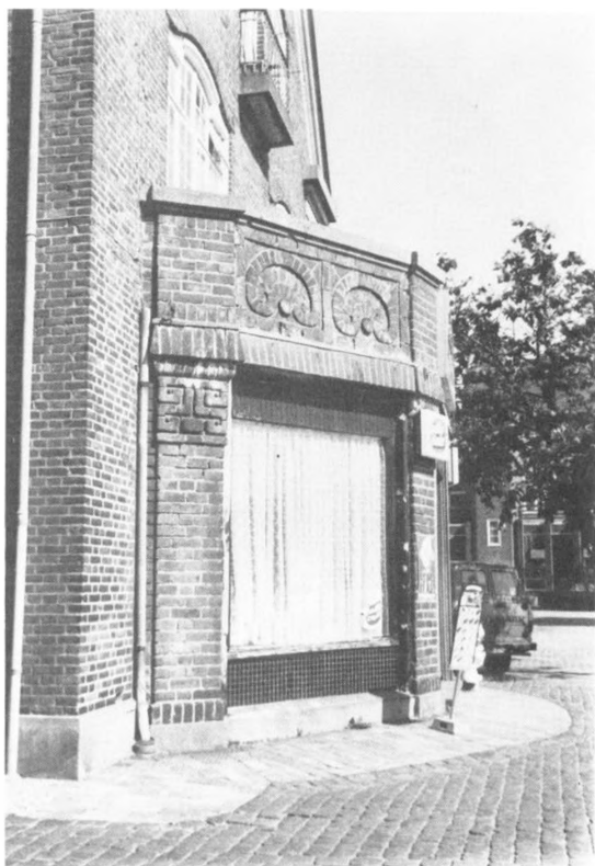
Priorgården er måske den mest »bindesbøllske« af Ulrik Plesners bygninger i Ringkøbing. Thorvald Bindsbøll har tegnet ornamenter til andre af Plesners bygninger. Foto: Nina Dablmann Olsen.
