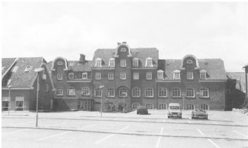
Asmildkloster Landbrugsskole er Ulrik Plesners største samlede byggeopgave i Midtjylland. Foto: Nina Dablmann Olsen.
