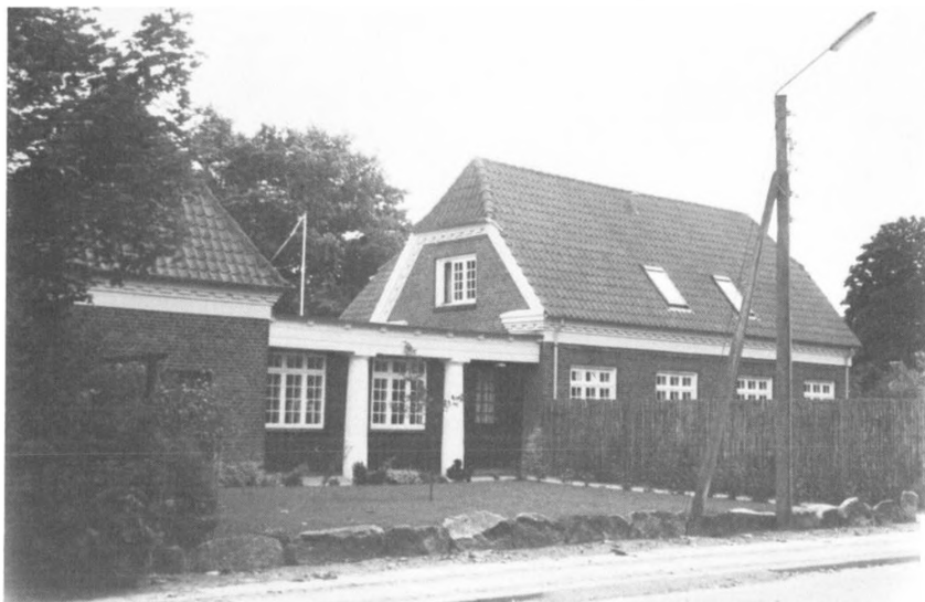
Den velbevarede stationsbygning i Spjald med hvidmalede søjler. Foto: Nina Dahlmann Olsen.
