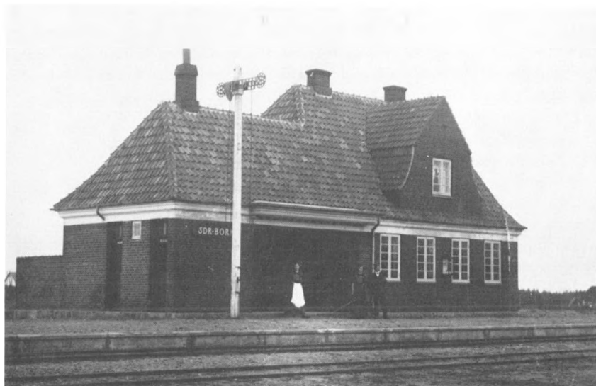
Sdr. Bork station. Signalmasten på perronen har en signalarm gældende for hver køreretning. Signalarmen har kun betydning for et mod signalet kørende tog, når armen set fra toget ses til højre for masten. Armen vandret betyder stop. Armen skråt opefter betyder kø. Foto: Museet for Varde By og Omegn.
