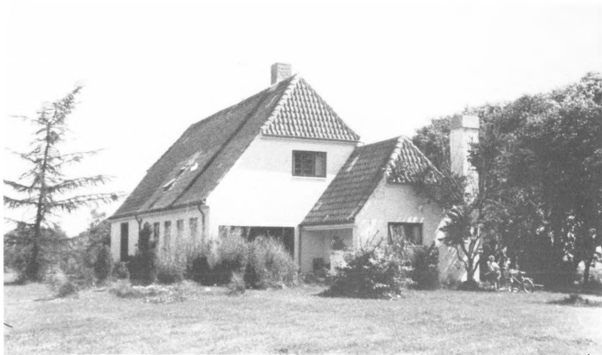
Sønderbæk station er den bedst bevarede af Ulrik Plesners stationsbygninger på Viborg-Fårup-banen. Foto: Nina Dahlmann Olsen.
