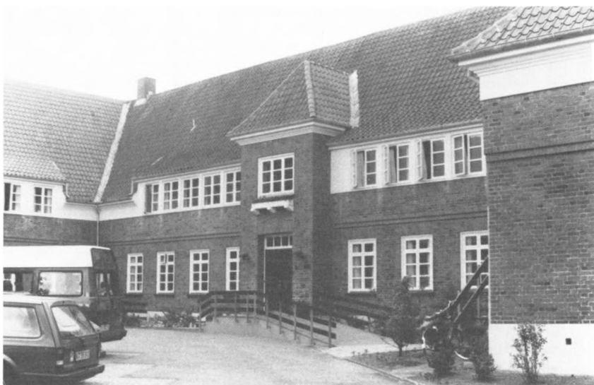
»Sysseting« har valmtag og kraftig hvid gesims med hulkebl. Overetagen er camoufleret som mansard. Foto: Nina Dahlmann Olsen.
