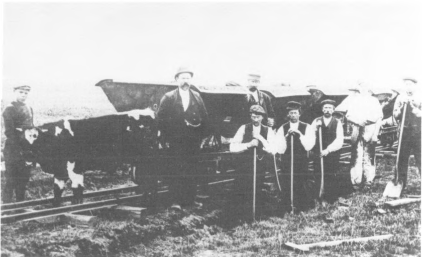
Anlægsarbejde på strækningen mellem Nr. Børk og Sdr. Vium. Foto: Arkiv Hans Jørn Fredborg.
