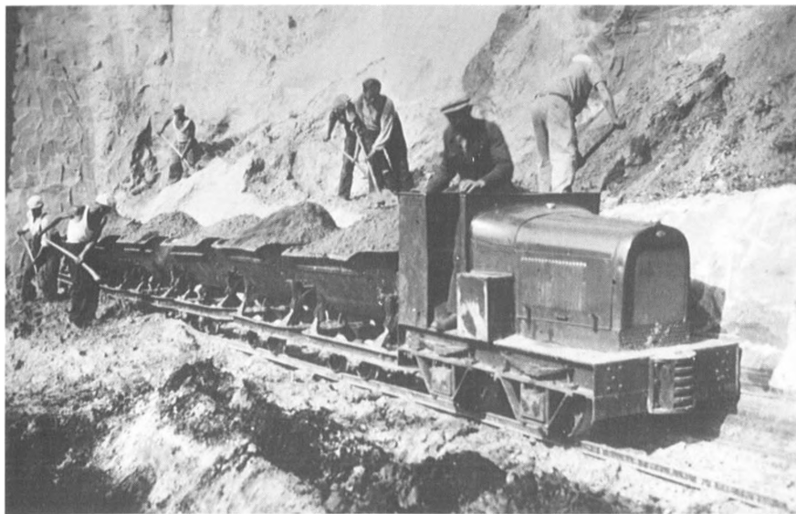
Overjord læsses i tiprogne i Skaks kulleje i Fiskbæk 1940. På traktoren ses Aksel Frandsen. (Foto: Nationalmuseet)
