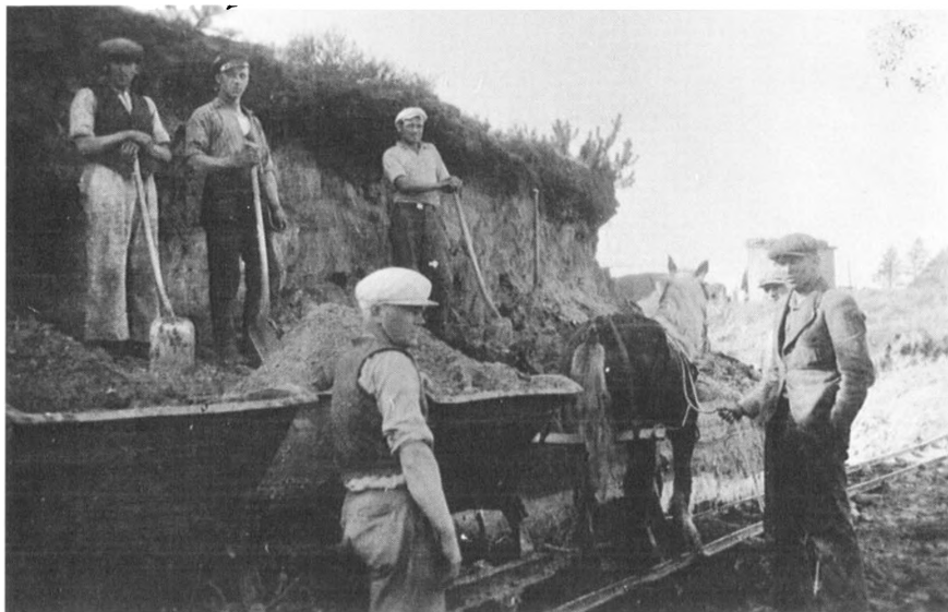
Overjord læsses i Skaks kulleje i Fiskbæk 1941. Tøpvojnene trækkes ud på tippet af besten »Peter«. Forrest til venstre ses Søren Risvig og til højre for ham formanden Kristian Skak. Bagerst ses fra venstre Kristen Holm, Reinhardt Nielsen og Aage Hansen. (Foto: Nationalmuseet)
