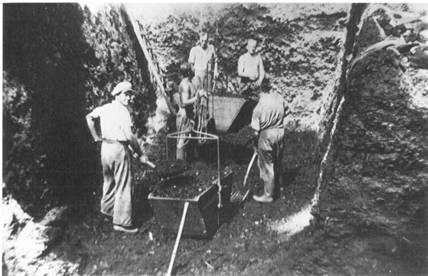
Kul læsses i kasserne nede i kullejerne i Laumanns leje i Ejstrup 1943. Manden med rebet styrer svingbommen, når kasserne går op. De øvrige løsner kul med hakker og grebe. (Foto: Nationalmuseet)
