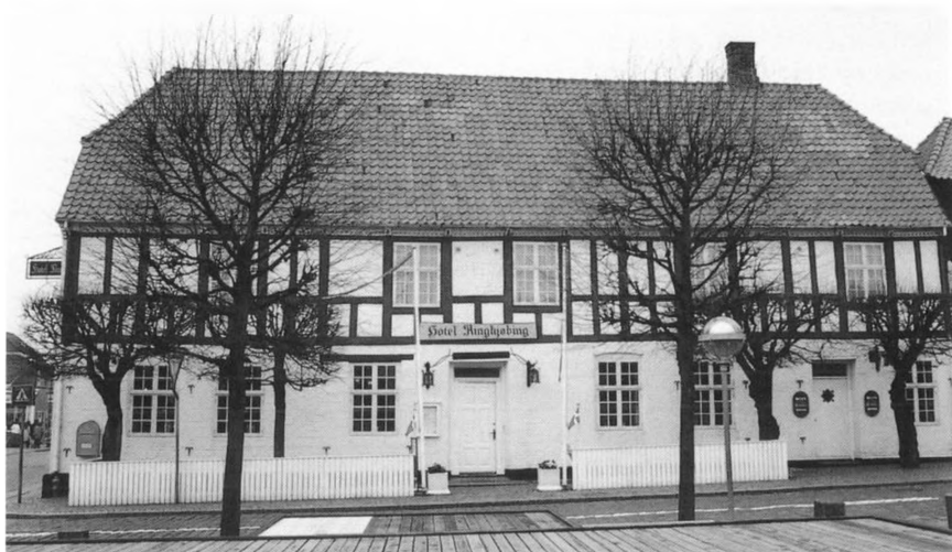
Hotel Ringkøbing, som det ser ud i dag. Oprindeligt var huset helt i bindingsværk, men det er nu kun bevaret i overetagen.
