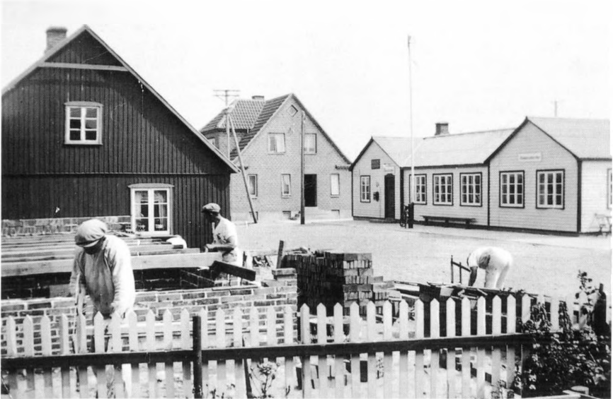
Murermester Anders Kusk Christensen opfører hus til malermester Niels Enevoldsen i Bredgade o. 1939. I baggrunden sømandshjemmet og den nyopførte telefoncentral tilhørende Thyge Vembs døtre Jensine og Nielsine Nielsen (Restaurant Slusen). Det mørke træhus tømrer og glarmester Jens Jensen.
