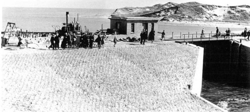
Færdig kammer-sluse med manøvrehus. Den store arbejdsplads var et populært udflugtsmål. Der plantes helme for at dæmpe sandflugtsplagen. (A. Grimstrup)
