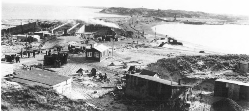
Byggepladsen set fra Troldbjerg. Slusekamrene er ført op til færdig højde. I baggrunden kammer-slusen. (A. Grimstrup)
