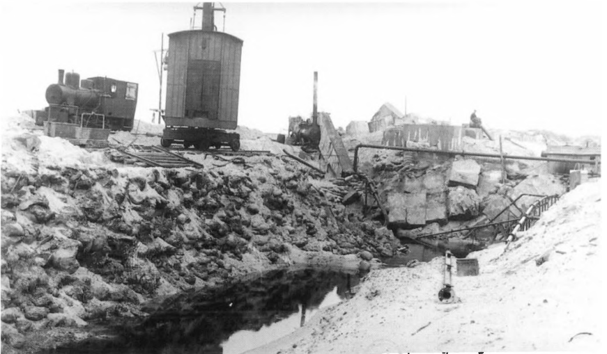
Gennembrydning af sikringsmolen. Der dannes en 70 meter bred og 5 meter dyb åbning. Det er store mængder, der i årene 1912-15 er blevet hældt i dybet for at lukke Hvide Sande kanalen. (A. Grimstrup)
