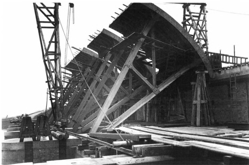
Stigbordene på slusens østside bygges på stedet. (A. Grimstrup)
