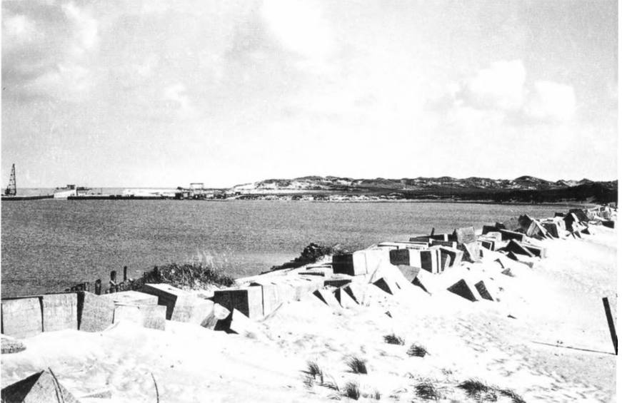
Den gamle mole, der lukkede Hvide Sande i 1915, ligger stadig ubrudt og sikrer byggepladsen mod havet. I baggrunden den færdige kammerluse. Set mod SØ. (A. Grimstrup)
