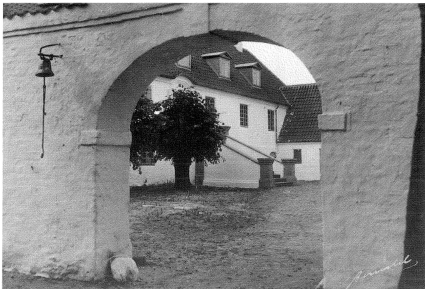
Indkørslen gennem porten til hovedbygningen.
