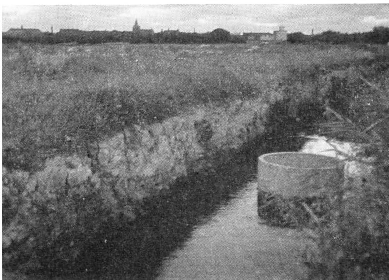
Fig. 19. Marskler i udgravning til en kloakledning i engen vest for Ringkøbing, der ses i baggrunden. Tørven rager op som balkler mellem gamle tørvegrave, i hvilke marsken er blevet aflejret.
