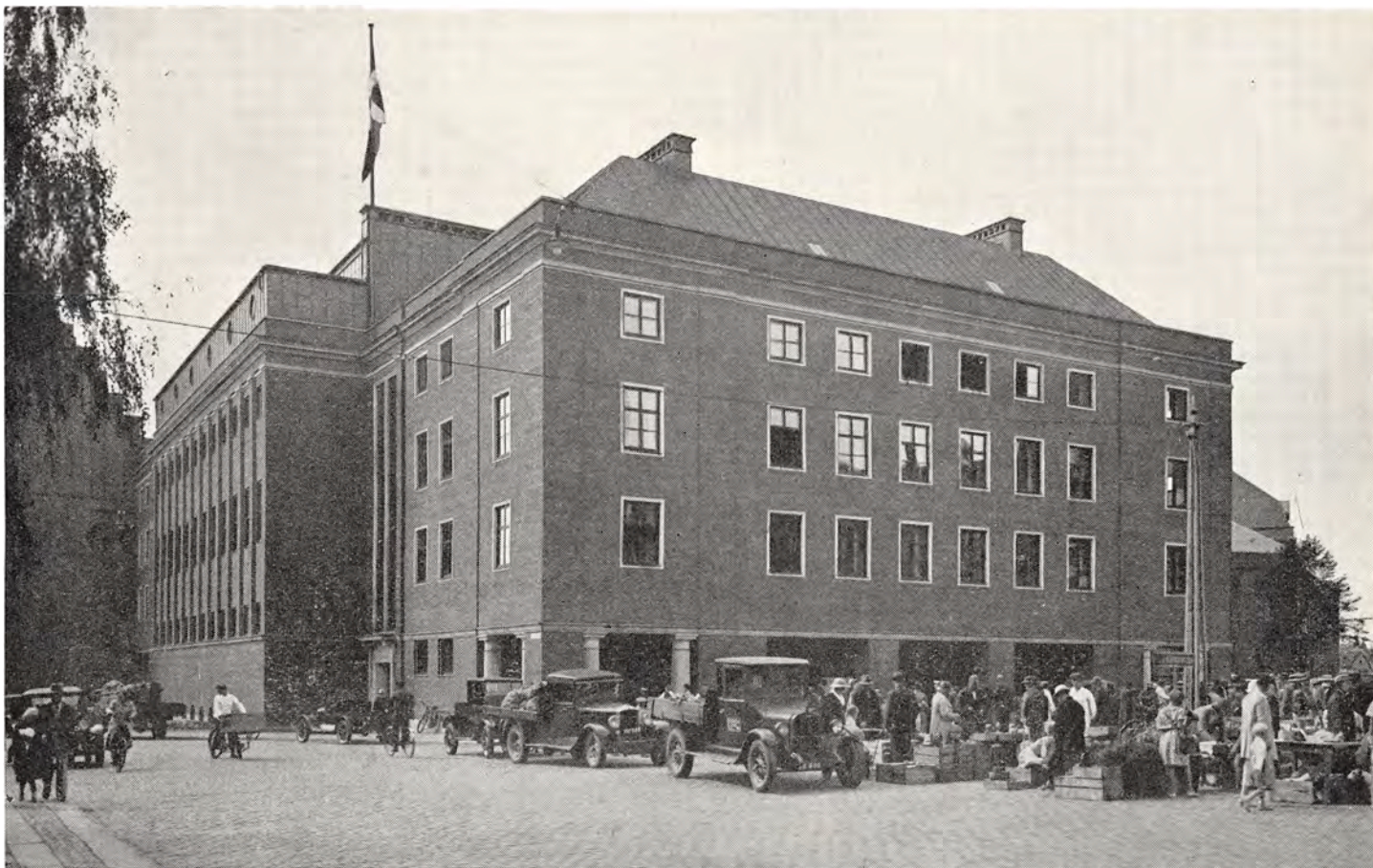
Telefonhuset i Odense. Opført 1934—36.
