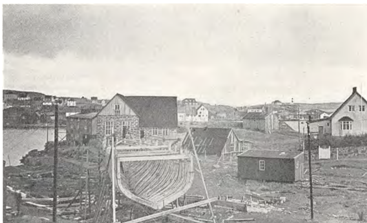
Thorshavn Elektricitetsværk. Tilhøre derfor Gavlen af Driftsbestyrerboligen. I Forgrunden Skibsværftet. Helt i Baggrunden tilhøre for E.-V. ses Vandbygningsvæsenets forhv. Ingeniørkontor og tilhøre derfor igen „Skansen“ med Fyret.
