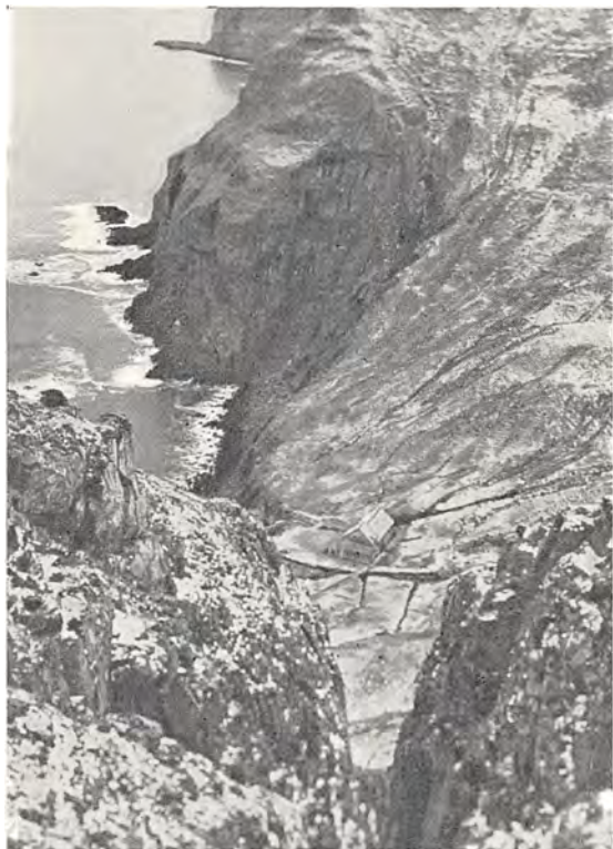
Vaag kommunale Elektricitetsværk set gennem Kløf-ten ved „Stlgarnir“ (180 m o. H.). Kraftstationen er de fleste af Aarets Maaneder utilgængelig fra Søsiden p. G. af Brænding.
