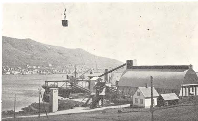
A/S Færø Kuls Udskibningsanlæg ved Drelnæs. En tømt Kulkasse ses paa Vej op til Minen. Tilvenstre Transformortårnet og tilhøjre A/S North Atlantic Salt Companys Saltsilo (Kapacitet ca. 10.000 t).
