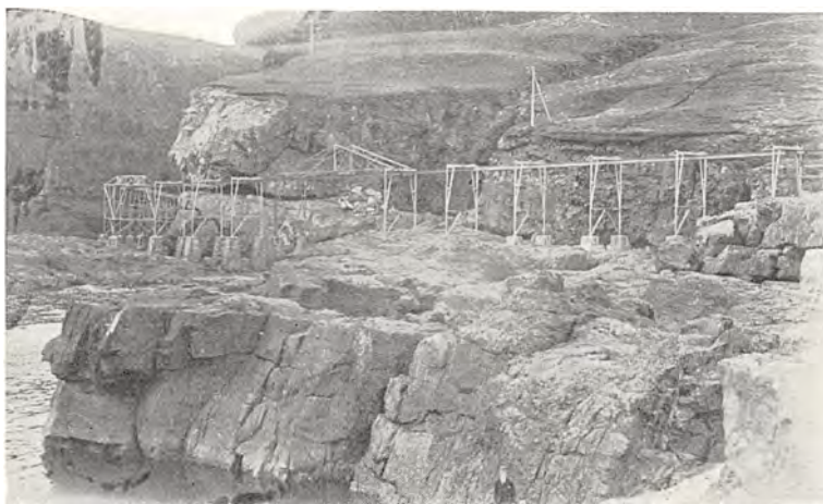
Kørebanen ved Vågs Eidi. Baadene sættes ud og tages op i Kløften i Baggrunden. Køretiden med Banen er ca. 90 Sekunder i hver Retning.
