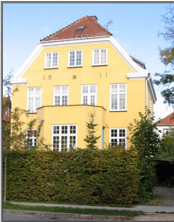
Ingolfs Allé 24, hvor de bor i stueetagen fra 1914-16
