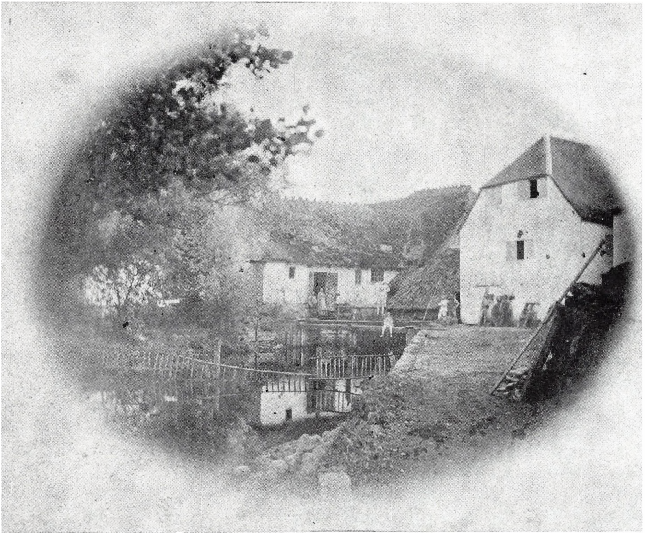
Hollose mølle. Ubekendt fotograf. Foto i privat eje. Billedet er øjensynligt taget fra »mølleøen« lige neden for goldslusen, så vi ser indløbet til møllehjulene under det lave, skræ tag. Der er lavet spærring med tremmer for at stoppe grene og lignende, der kunne komme drivende med vandet. Huset til højre må være selve møllebygningen med kværnene. Til venstre en fløj af beboelseshuset. jfr. Philip Smidths situationsplan.
