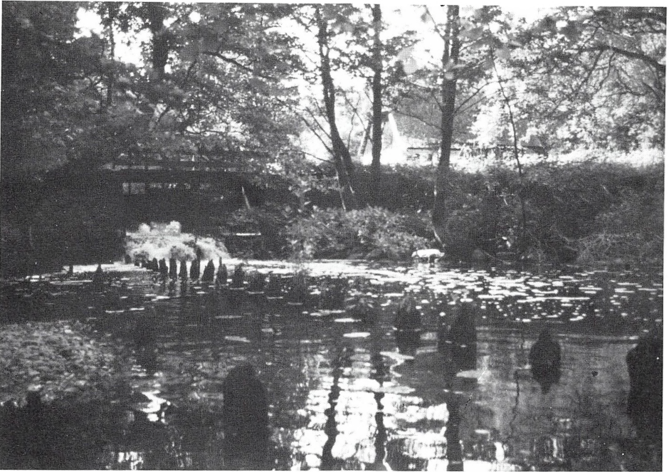
Rester af piloteringspæle under Holløse kammerluse. Fot. J. I. P. 1980.
