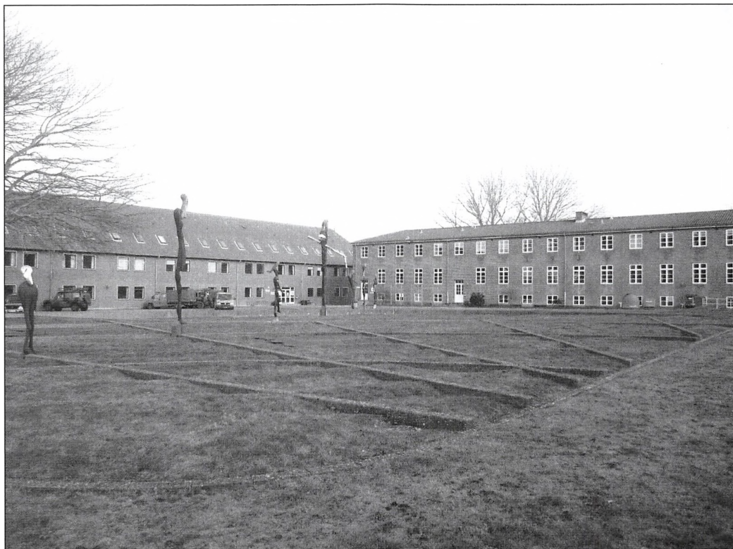
Frederik den 5. gård med den tidligere kostforplejning og bygning Vejle samt Bjørn Nørgaards store kunstværk „Vagterne i den nye Verden“.
