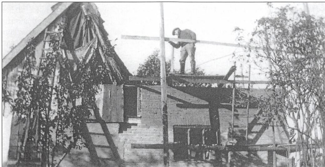
Det blev et af Wolles livsprojekter at bygge om og til på huset i Mosen. Her er det en vinkeltilbygning med køkken og atelier, han arbejder på.
