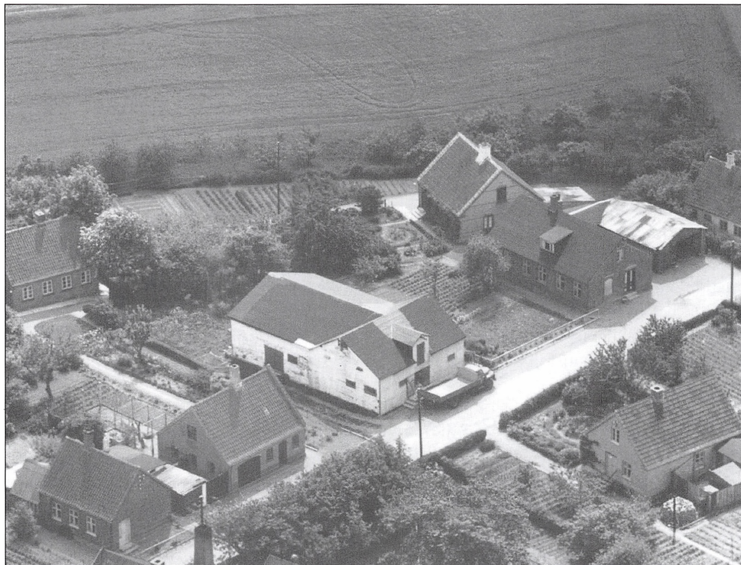
Bogø Foderstofforenings pakhús i Smedestræde, som det så ud i mange år. Foran læsserampen holder uddeler Aksel Jensens private lastvogn klar til at blive læsset til den ugentlige varetur. Uddelerboligen er villaen til højre for pakhúset (Aerodan Luftfoto).
