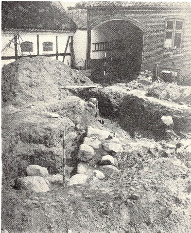
Fundamenter til nordmuren med dens støttepiller.
