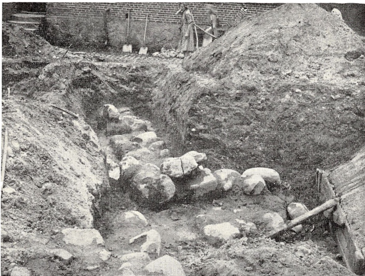
Forrest til venstre et hjørne af tårnfundamentet. Længere tilbage grundsten til sydmuren af kirkeskibet med støttepille.
