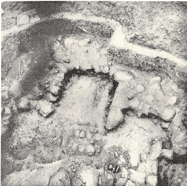
Fundamenterne til tårnet og det vestlige af skibet. Man skimter det bevarede stykke af forbindelsesmuren mellem tårn og skib. Nordhjørnet af tårnfundamentet endnu ikke afdækket. Billedet taget 10—12 m over gårdspladsen fra en brandstige.
