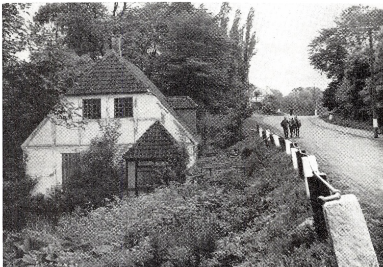
E. Glückstadt, der købte ejendommen 1934 af von Rehling-Qvistgaards bo, solgte 1945 den gamle, af kaptajn Lind opførte vandmølle, til nedrivning. Fotografiet er taget samme år.
