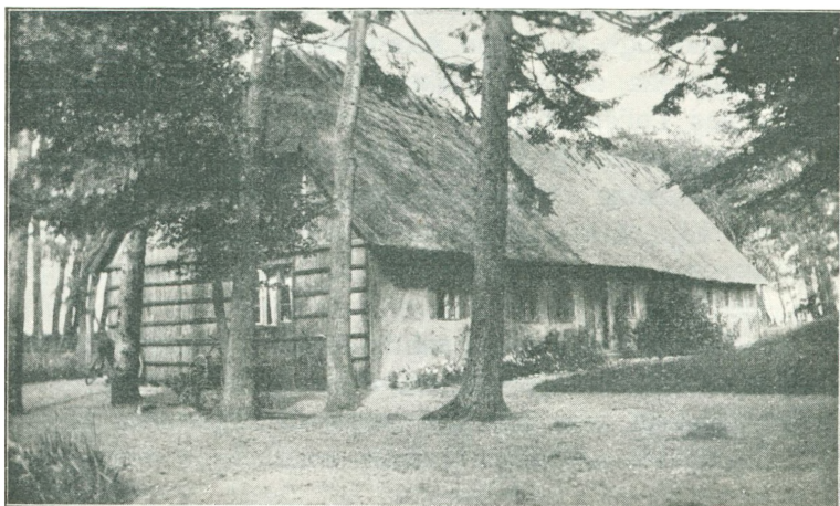
Fig. 6. Det nuværende Færgarhus i Grønsund, opført 1839. Til højre ses lidt af Skansen fra 1659. (Fot. Svend Jørgensen).
