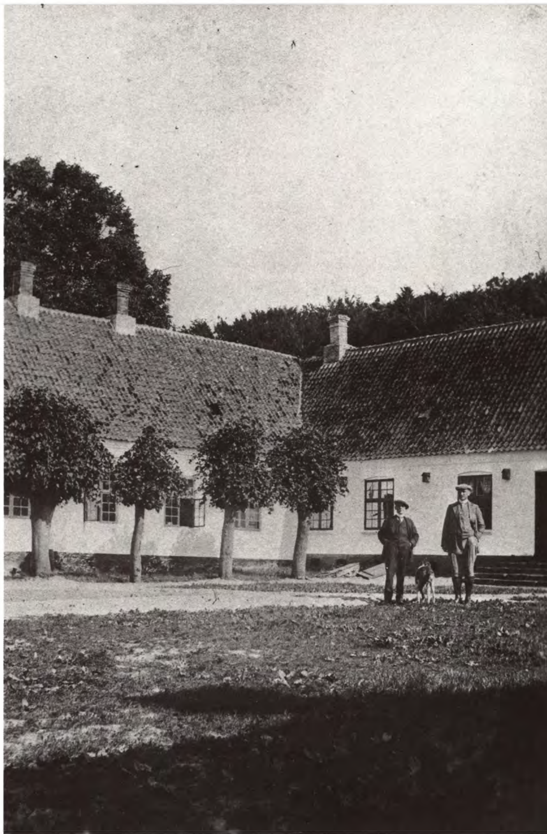
Gårdsiden af hovedbygningen på Gudumlund.
