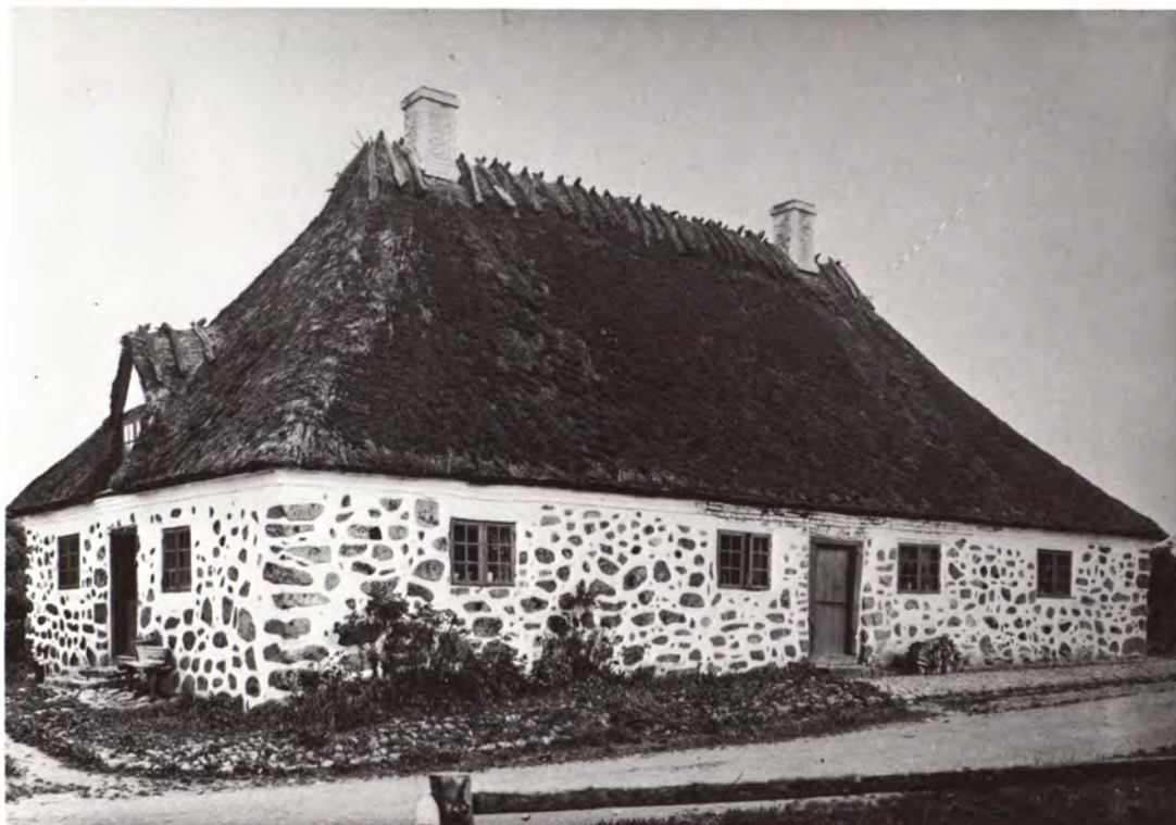
Diernisse Hospital blev fotograferet i 1908 af Mourits Mackeprang fra Nationalmuseet. Et tilsvarende fandtes i Katterød, som nu er flyttet til den Fynske Landsby, frilandsmuseet ved Odense. Begge stiftelser skyldes ejeren af Holstenshus. De er bygget midt i 1700'erne af kløvede kampesten sat i ler og fuget med kalkmørtel. Nogle sociale foranstaltninger bliver med tiden forældede og kan da komme til at virke mod den oprindelige hensigt.
