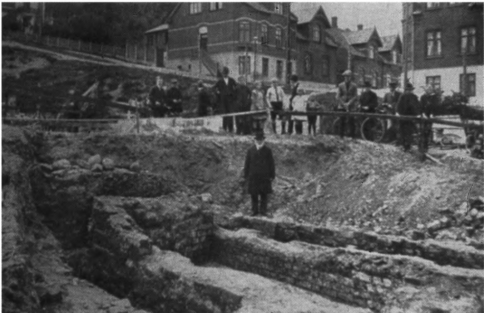
ETK stående i udgravning af teglønnen. I baggrunden husene på Jagtvej
