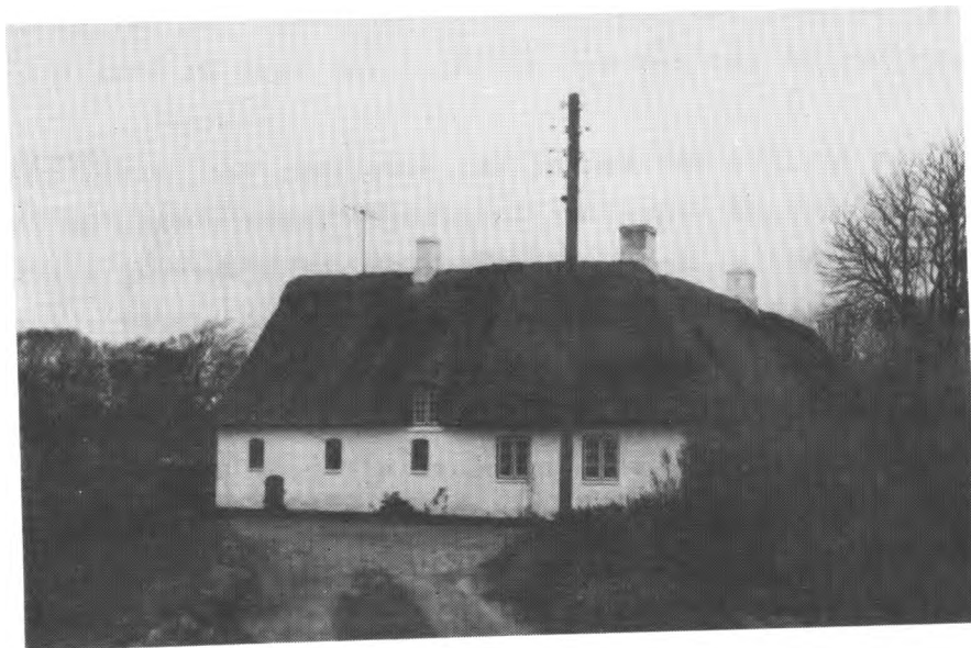
Rytterhuset fot. i 1966.
