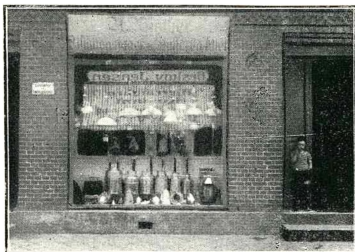
A. Winthers Blikkenslagerforretning.
