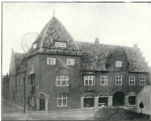
Løgstør Jernstøberi, Motor- & Maskinfabrik ved H. C. Hansen & Sahl.
