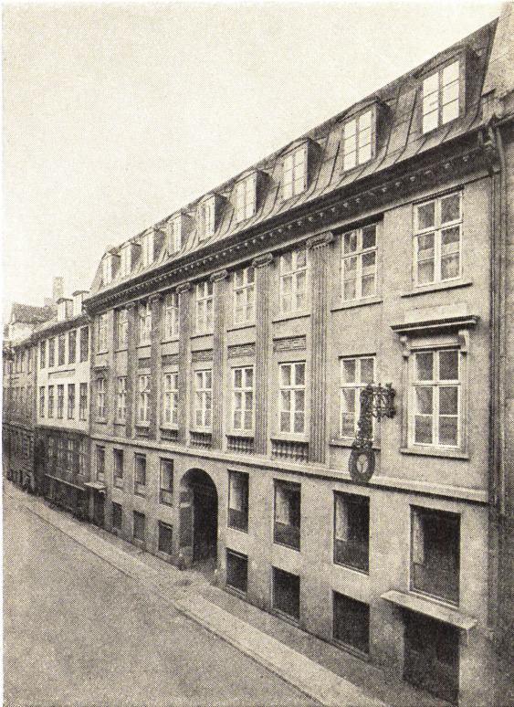
Badstuestræde 18. Carl Dahléns Bolig. Huset er senere ombygget.
