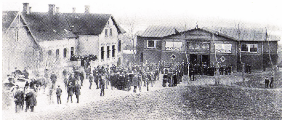
Vallekilde Højskole med det nyopførte gymnastikhus. T.v. ses den gamle hovedbygning. Det kgl. Bibliotek.
