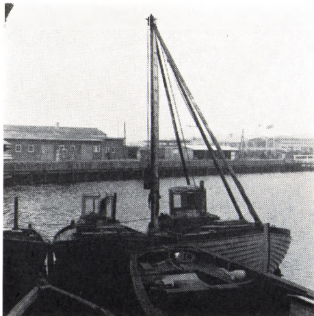
Rambuk til idrivning af bundgarnspæle.
