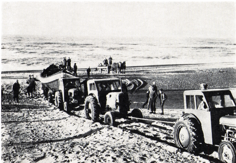
»Vedersø«-redningsbåden slæbes fra stranden ved hjælp af tre almindelige landbrugstraktorer, der dog på grund af forstrandens forskellige fasthed ikke altid har fuld magt over opgaven, men ofte kører fast med de store hjul hvirvlende rundt i det løse sand.
