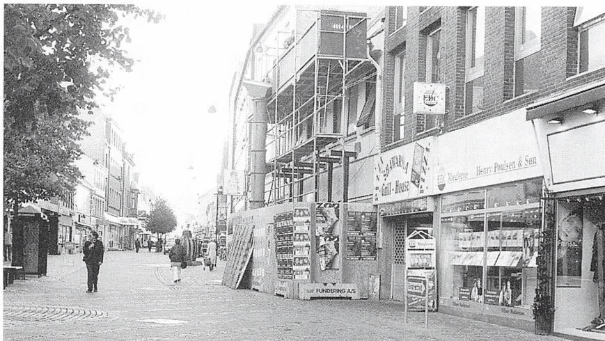
Fig. 1. Skomagergade 19 fotograferet i oktober 1997, da det var gemt bag plankeværk og med forhuset hængt op i jern. I billedets midte skimtes ruden i gadebelægningen, hvor man kan se ned til frådstensvejen, der udgravedes i 1993. Foto Hanne Dablerup Koch.
