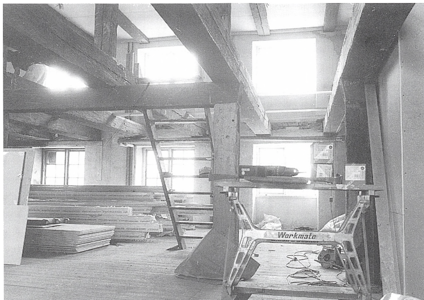
De lave lofter i Sukkerhuset under ombygning. Foto Flemming G. Rasmussen.
