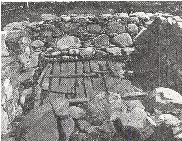
Fra udgravningerne af det hanseatiske kvarter, Tyskerbryggen, i Bergen, af hvilket der trods ødelæggelser er bevaret en stor del. Det afbildede hus har haft stenmure funderede med træpæle i den bløde undergrund, og i stedet for at nøjes med ler eller sten har man lagt et trægulv.
