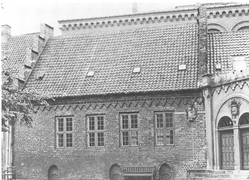
Bygningen fra ca. 1420 bag Universitet på Frue Plads, som efter Københavns Universitets oprettelse i 1479 blev brugt til konsistoriums møder, er den ældst bevarede verdslige bygning i København. Den hvælvede kælder blev i 1626 indrettet til fængsel. Fot. ca. 1900. Københavns Bymuseum.
