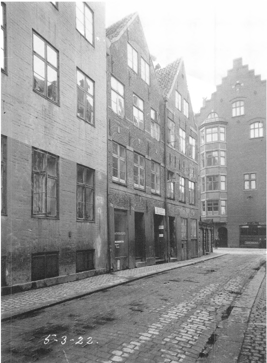
Fig. 4. Magstræde 17-19. De to huse, er opført i 1620rne, er blandt de få gavlhuse, der er bevaret i København. Oprindeligt havde de kun to etager, men allerede i 1712 tre. Foto 1922, Københavns Bymuseum.
