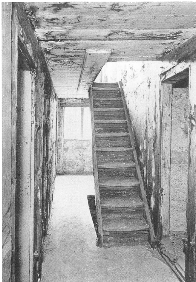
Fig 18. Adelgade 91. Trapperummet med trappe og døre ind til køkkener og stuer. Fot. Niels Elswing under husets nedrivning i 1954. Nationalmuseets 3.afd.
