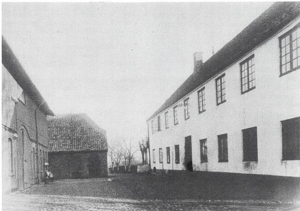
Tønder fattig- og arbejdsanstalt på Gørrismark, opført 1854, og i brug som fattiggård indtil 1937, idag nedrevet. Fot. Institut for Sønderjysk Lokalhistorie.
