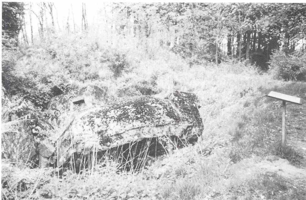
Sprængte betonrester af Gammelskov-batteriet nordøst for Toftlund - med Sønderjyllands amtskommunes orienteringstavle om hvad man ser på stedet. Fot. 1988 P. Thorning Christensen.
