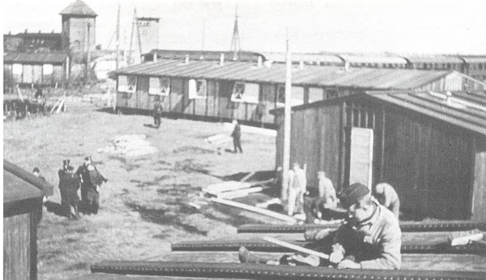
CBU i Sønderjylland stod for opførelse af karantænestationer. Barakelementerne var allerede i 1943 blevet opmagasineret i Haderslev, Tinglev og Sønderborg. Her er opførelsen igang i Padborg i efteråret 1944. I billedets baggrund ses DSB's vandtårn. Fot. Bov Museum.
