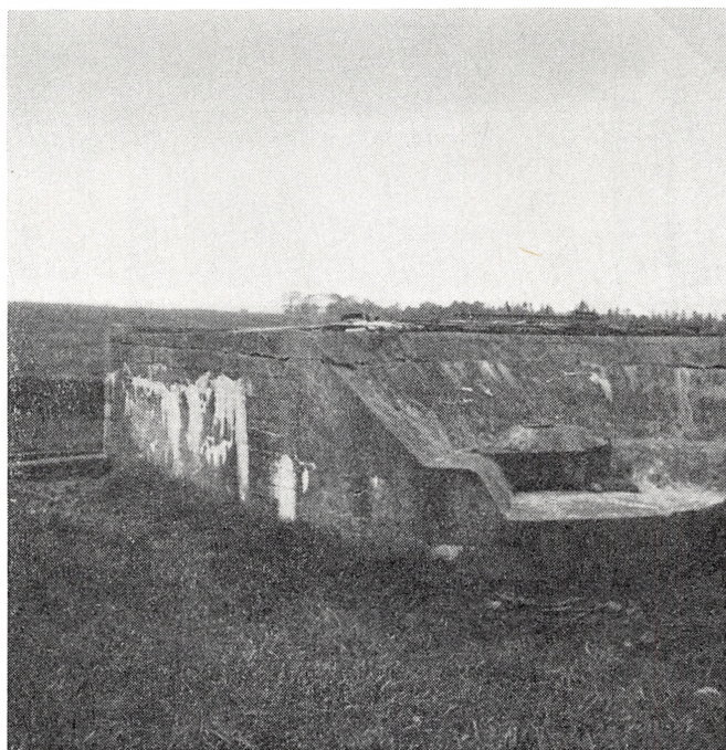
Øverste halvdel af observationsrum sammenbygget med posteringsrum med gård ved sydenden af vejen Arnitlund-Abkær mose. Bemærk hullet foroven i jernkonstruktionen foran – det er beregnet til periskopudkig; nedenunder flere kighuller med udsyn mod nord.
