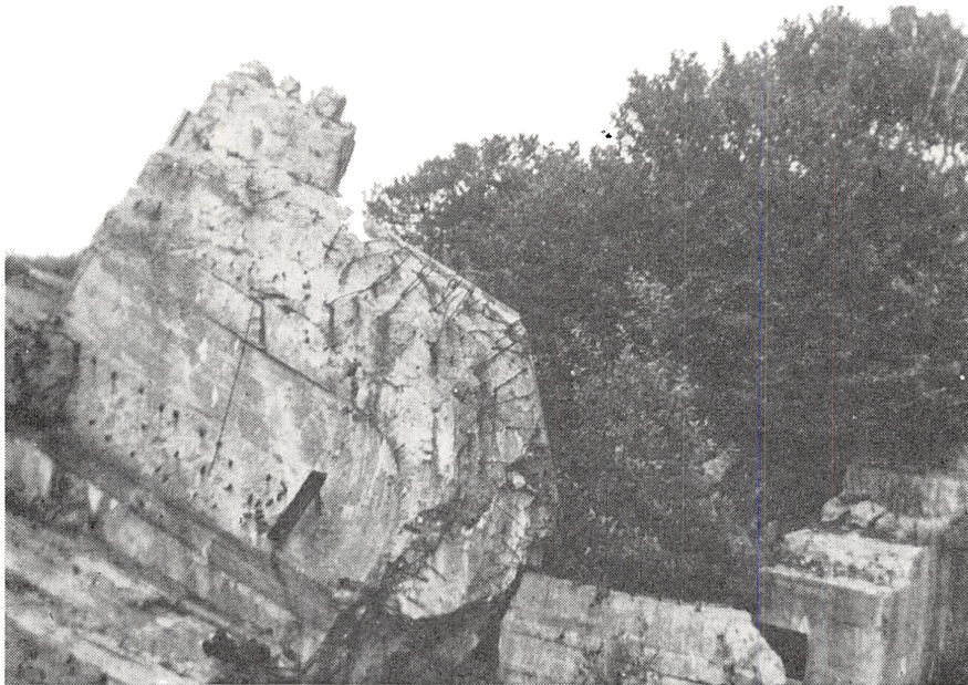
Ruinerne af betonrummene prægede landskabet i 1930'erne. På undersiden af den store loftsblok kan man se hvorledes en gang er gået ind fra venstre og drejet om den sorte jernbjælke. (Strandelhjørn 1937).
