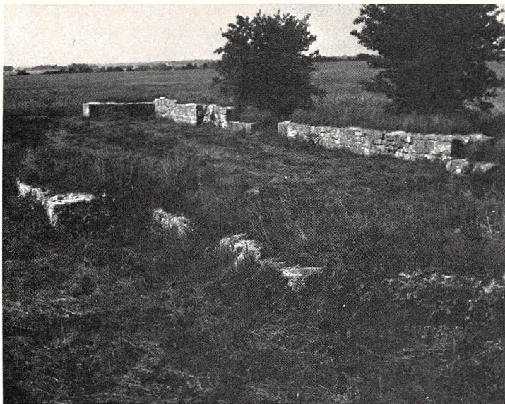
Fundamentet af Knud Lavards Kapel ved Haraldsted. Forf.fot.
