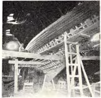
Kongens Sejlbaad under Opbygning.
