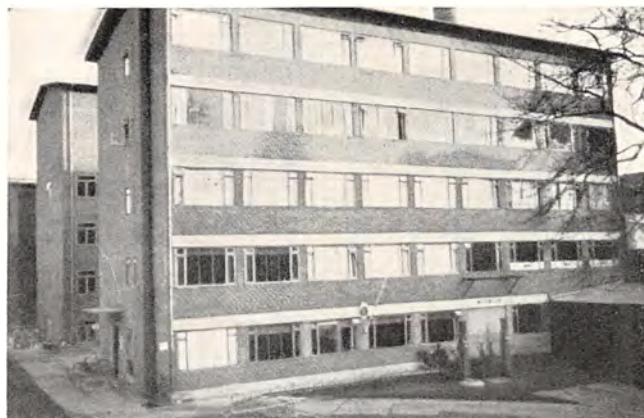
Bülowsvej 34. Bygning „A“.
