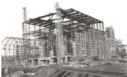
H. C. Ørsted-Værkets Melan-Konstruktioner under Opførelsen.
