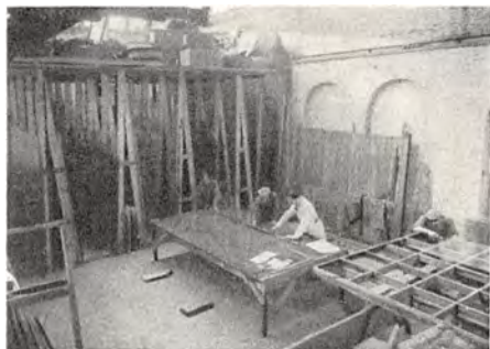
Interior fra Stenfeldt Hansen's Spejlglaslager.
