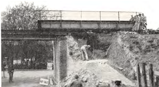
Pedersborg Viadukten under Opførelse, den gamle Bro transporteres bort.
