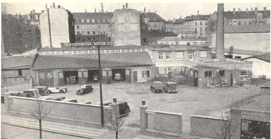
Værksted og Lager med Service-Station, Lundtoftgade 106.
