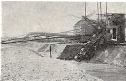
En Gravemaskine ved Haarbølle.
