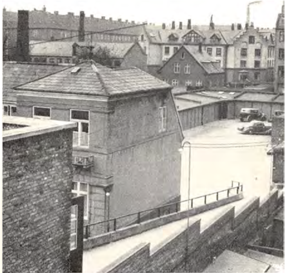
Garage med Opkørsel til 1. Sal i Hovedbygningen.
