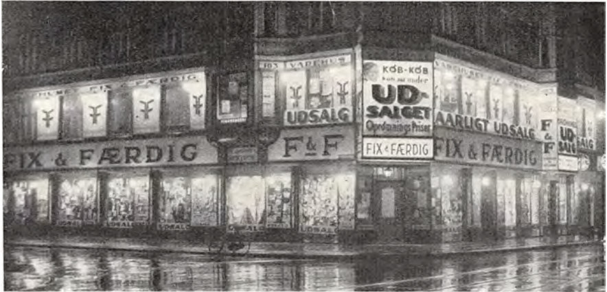
Eksterior fra Varehuset „Fix & Færdig“, Nørrebrogade 183.
