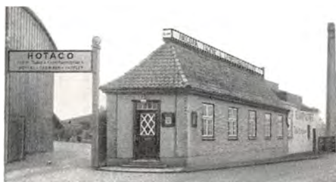
Kontorbygningen paa Sdr. Banevej.
