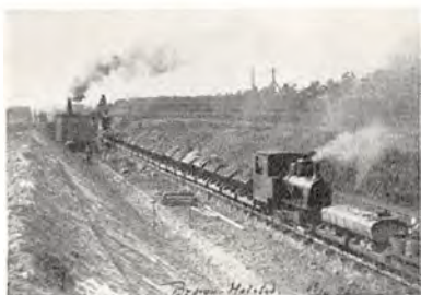
Udgravning ved Brørup-Holsted.
