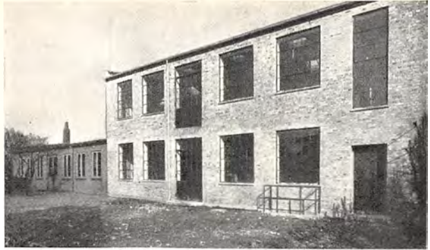
Kyrsting & Knudsens Elektromotorfabrik, Aalekistevej.
