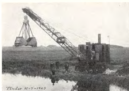
Udgravning ved Tønder.
