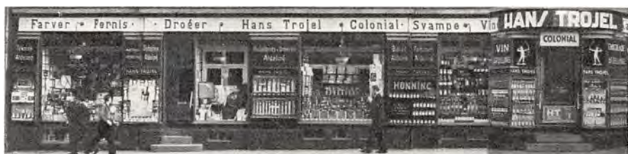
Eksterior fra Hans Trojels Stamforretning, Vesterbrogade.
