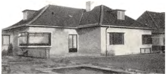
Arkitekt August Nielsen's Villa, Bernstorffsvej 6.
