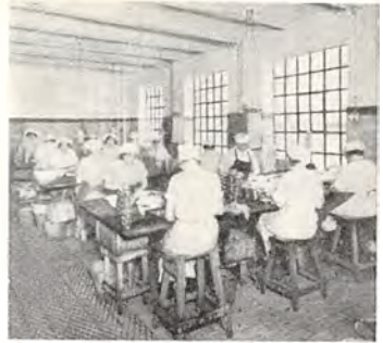
Interiør fra Fyrtaarnets Konservesfabrik.
