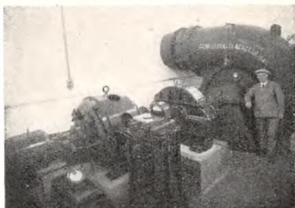
Pumpeanlægget ved Lammefjorden.
