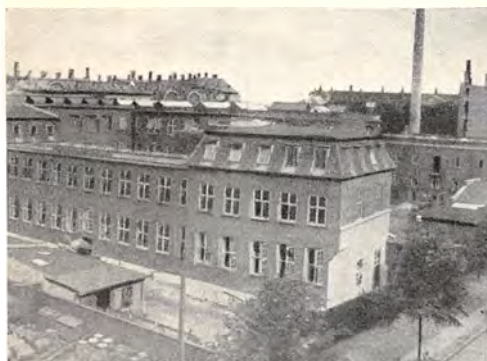
Fabrikken set fra Hesseløgade.
