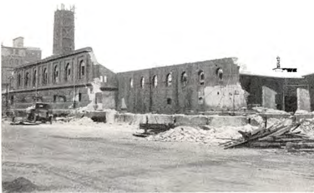
Østre Gasværk under Nedrivning.
