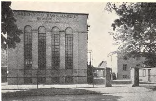
A/S Rosenberg Brøndanstalt, Sødring & Co., Bispevej 25.
