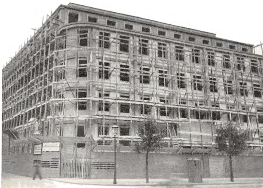
Overformynderiet under Opførelse.
