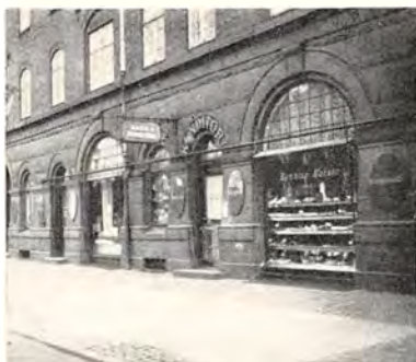
Hemming Hansens Konditori, Blegdamsvej 74.
