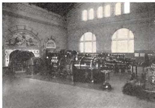
Maskinhallen i Elektricitetsværket.
