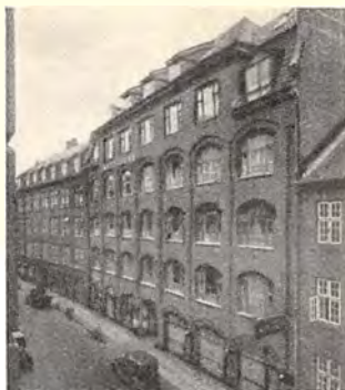
Firmaets Ejendom, Farvergade 17.
