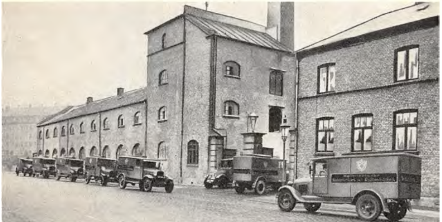
Københavnske Bagermestres nye Rugbrødsfabrik A/S, Heimdalsgade 29—31.
