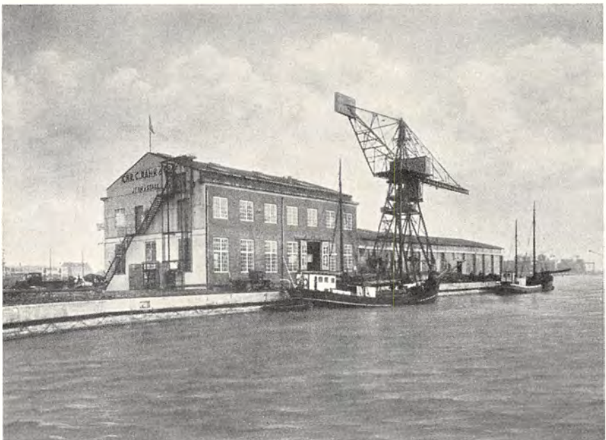
En Del af Firmaets Lagerbygninger og Kraninstallationer i Sydhavnen.
