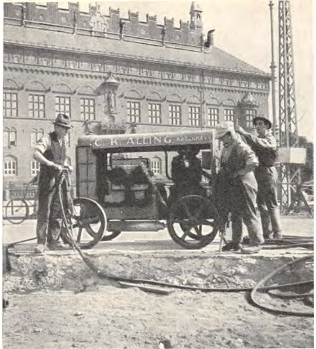
Opbrydning af Beton med et af „De blaa Trykluftanlæg“.
