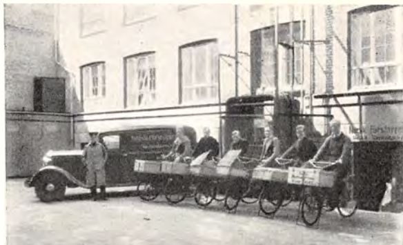
Eksterior fra Norsk Farsforretning, Vesterbrogade 80.
