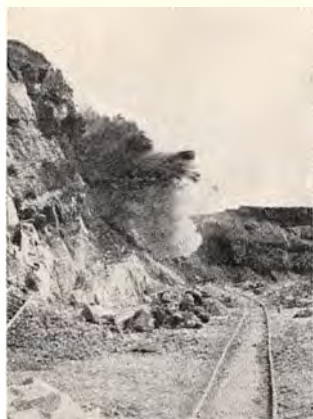
En Sprængning i Kalkbruddet.
