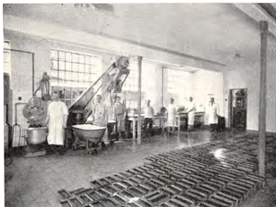
Interiør fra Charles Jacobsens Leverpostejfabrik.
