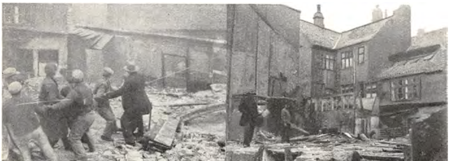
Nedbrydning af Torvegade 1933.
