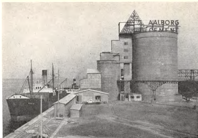
Lastning af Cement til Eksport ved Fabrikskaj.
