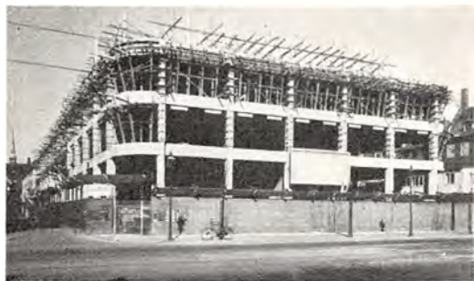
Overformynderiets nye Bygning under Opførelse.
