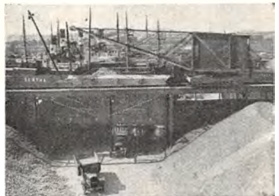
Siloanlæg i Gasværkshavnen.
