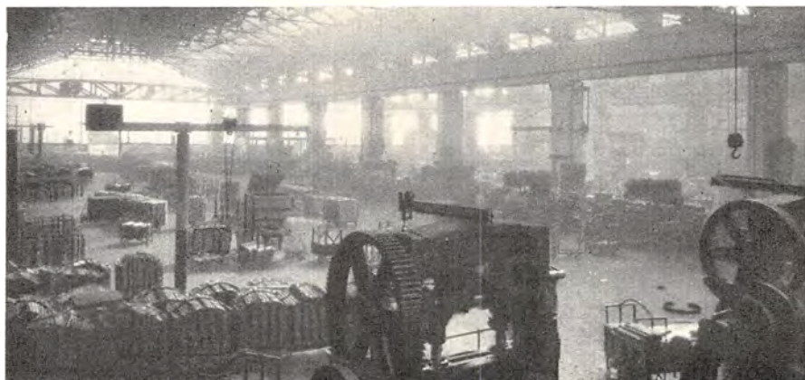
Interior fra H. Hollesens Fabrik.
