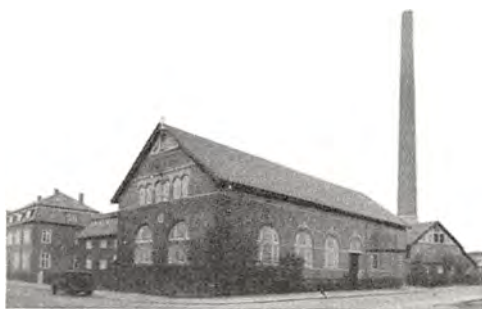
Elektricitetsværket i Aalborg.
