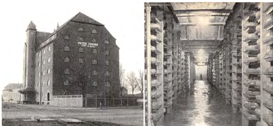
Pakhusejendommen i Sydhavnen og en Lagerkælder.
