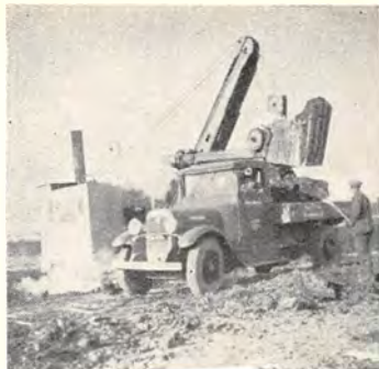
Gravkoen i Arbejde ved Grundudgravning til Nybygning.
