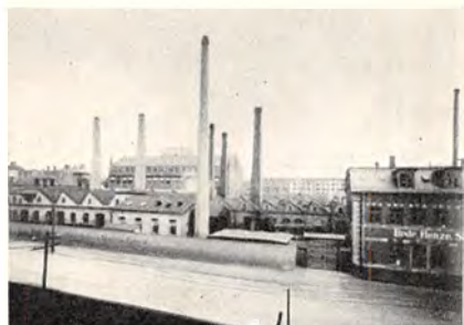
Brdr. Henze's Skruebolte- og Møttikfabrik
