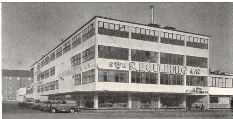
Firmaet S. Houlbergs ny Fabrikbygning i Kødbyen.
