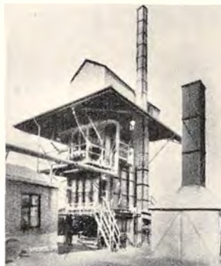
Vertikal Kammerovn paa Maribo Gasværk.
