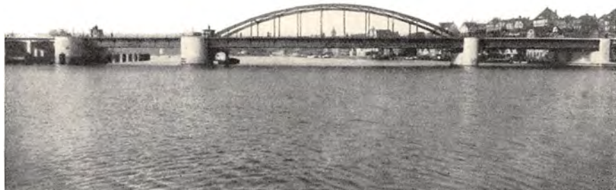
Kombineret Vej- og Jernbanebro over Alssund.
