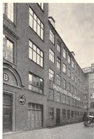
Carl Brørups Lagerbygning.
