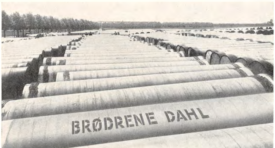
Delsending af en milclang Staalrørsledning, som „Brødrene Dahl A/S“ har leveret til Københavns Vandforsyning.
