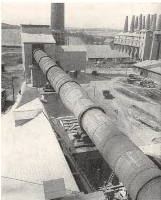
Verdens længste Roterov, igangsat 1935 paa A/S Aalborg Portland-Cement-Fabrik.
