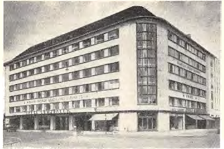
Shellhuset (opført af Entreprenør N. Mikkelsen-Sørensen).
