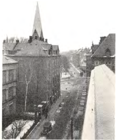
Udsigt fra Kontorbygningens Taganlæg.
