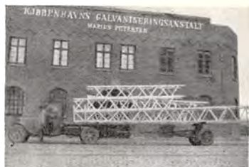
Galv. Master til Transformatoranlæg.
