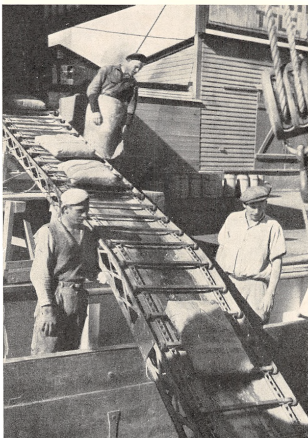
Lossearbejde ved Boas's Pakhuse i Kalkbrænderihavnen.
