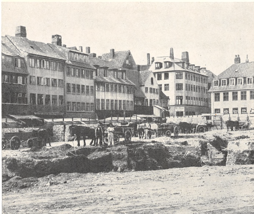
Parti af Vognmagergade under Sanering.
