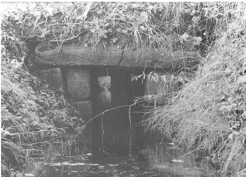
Fotografi 1987 af den af Marmillod byggede stenliste, der den dag i dag leder vandet under Kongevejen ved Løgsø i Rude Skov. Foto J. H. Tiemroth.
