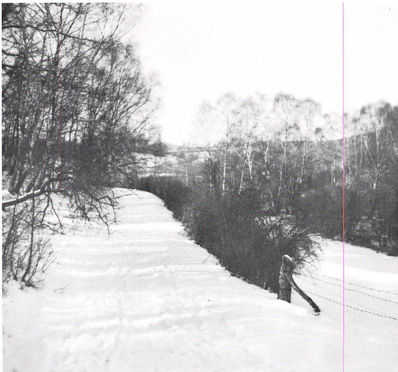
Fig. 29. Foto 1956. »Den grønne Sti« lidt nord for den dybe udgravning til denne sti, hvorover en bro nu fører Kirkestien. Den udgravede jord blev anvendt til at danne den afsats, hvorpå det viste parti af »Den grønne Sti« blev lagt. Til højre skråningen ned til Nærums Vestermose. Til venstre skrænten på Søllerøds side af markskellet. Rester af det gamle stendige og af K: Waldemars Vei mangler helt, men begge fulgte her markskellet, som stien gør det i dag.
