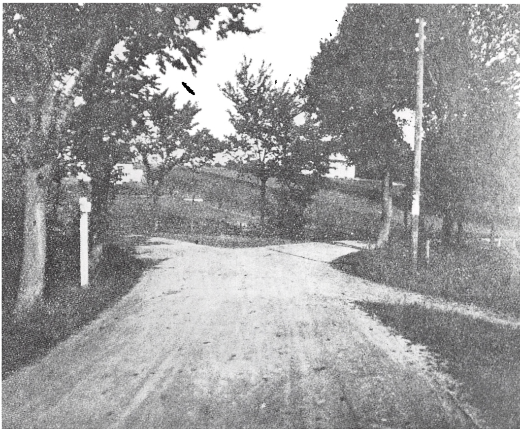
Fig. 2. Foto ca. 1918. Man ser, hvorledes landevejen kommende fra Kongevejen (i dag Skodsborgvej), efter at have passeret syd om Krag's Mose, deler sig i Attemosevej til venstre, vejen ned til Nymølle, nu Vangeboled, til højre, og i midten Nærumvej, der vistnok på det første stykke ind over Koføedsminde tidligere kaldtes »Smutgærde«.
