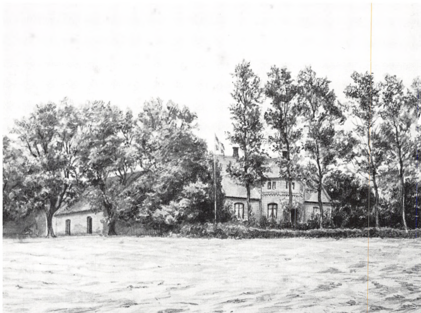
Havarthigård. 1860'erne var velstandsår for landbruget. I disse år byggedes de karakteristiske grundmurede gårde ud over landet. Også Hanne og Hans Nielsen lod opføre nye bygninger i 1861-67. Gården blev opført af røde mursten fra gårdens eget teglværk. Søllerød Byhistoriske Arkiv.
