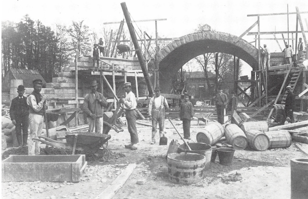
Viadukten i Skodsborg under opførelse i maj 1896. Året efter blev kystbanen åbnet.
